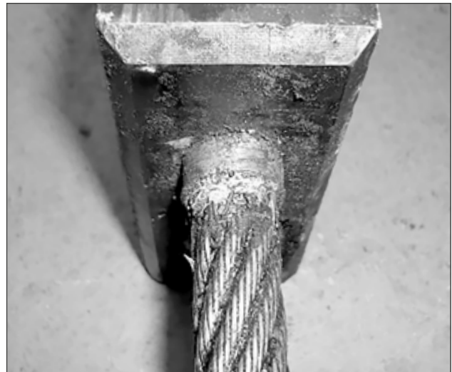
Abb.: Übermäßiges Herausrutschen des Vergusskegels aus der Vergusshülse
